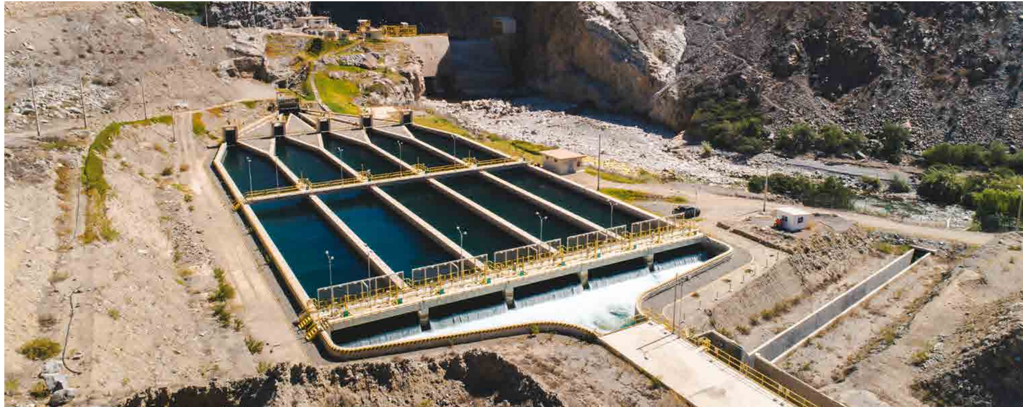
Central hidroeléctrica El Platanal, CELEPSA. Lima, Perú.
