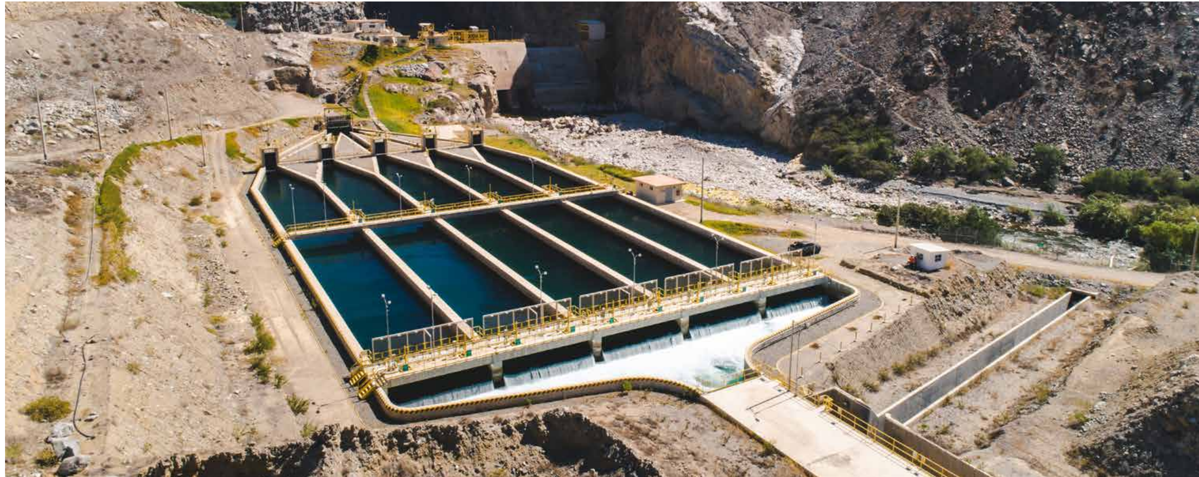
Central hidroeléctrica El Platanal, CELEPSA. Lima, Perú.
